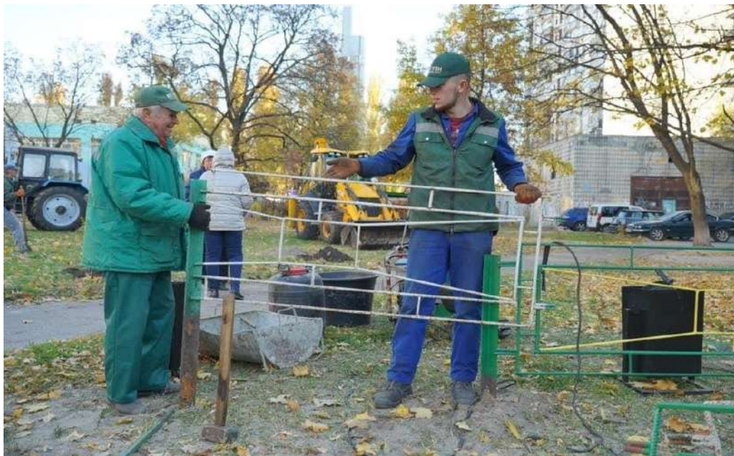
Поточні роботи ремонтно-будівельної дільниці підприємства
