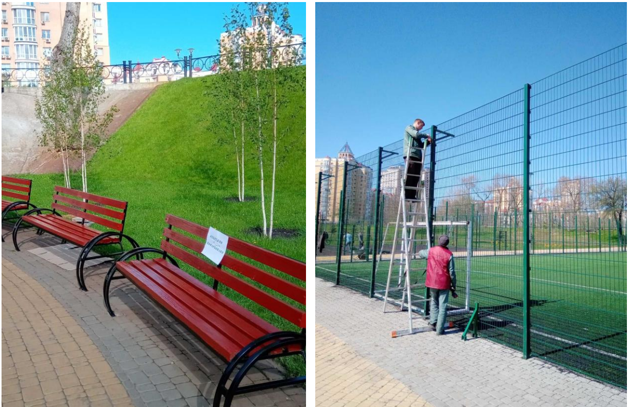
Поточний догляд за елементами благоустрою (ремонт, фарбування)
