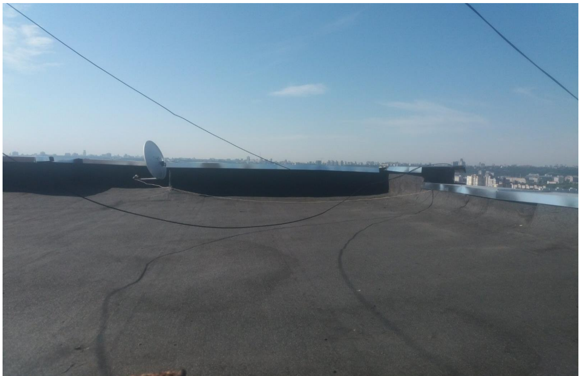
Капітальний ремонт покрівлі (на умовах співфінансування), просп. Героїв Сталінграда, 16-Б
