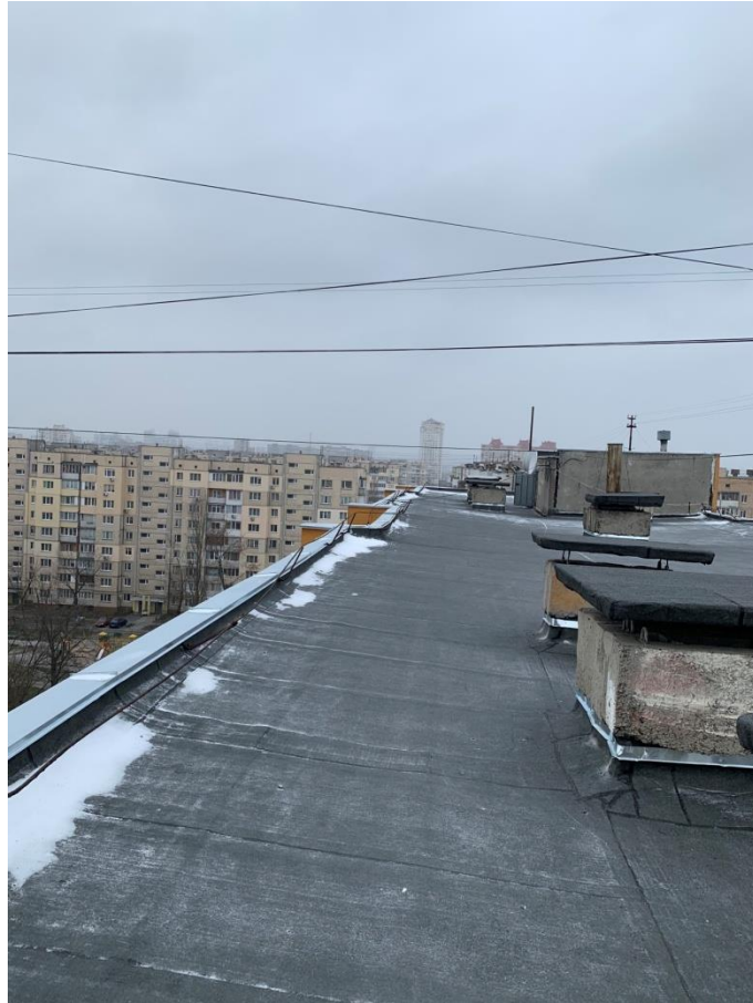
Капітальний ремонт покрівлі (на умовах співфінансування), вул. Північна, 54-А
