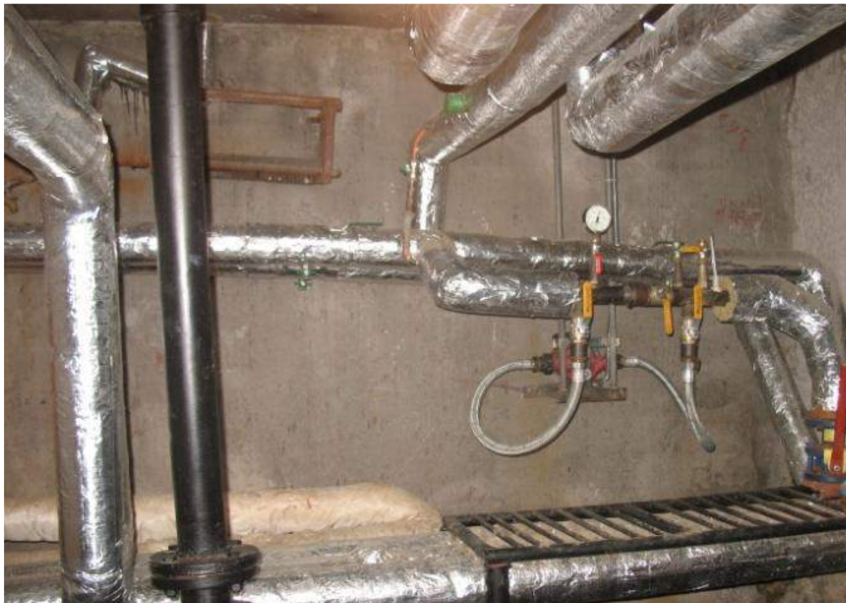
Заміна та ізоляція внутрішньо-будинкових інженерних мереж за адресами: вул. Березанська, 12А та вул. Героїв Дніпра, 3
