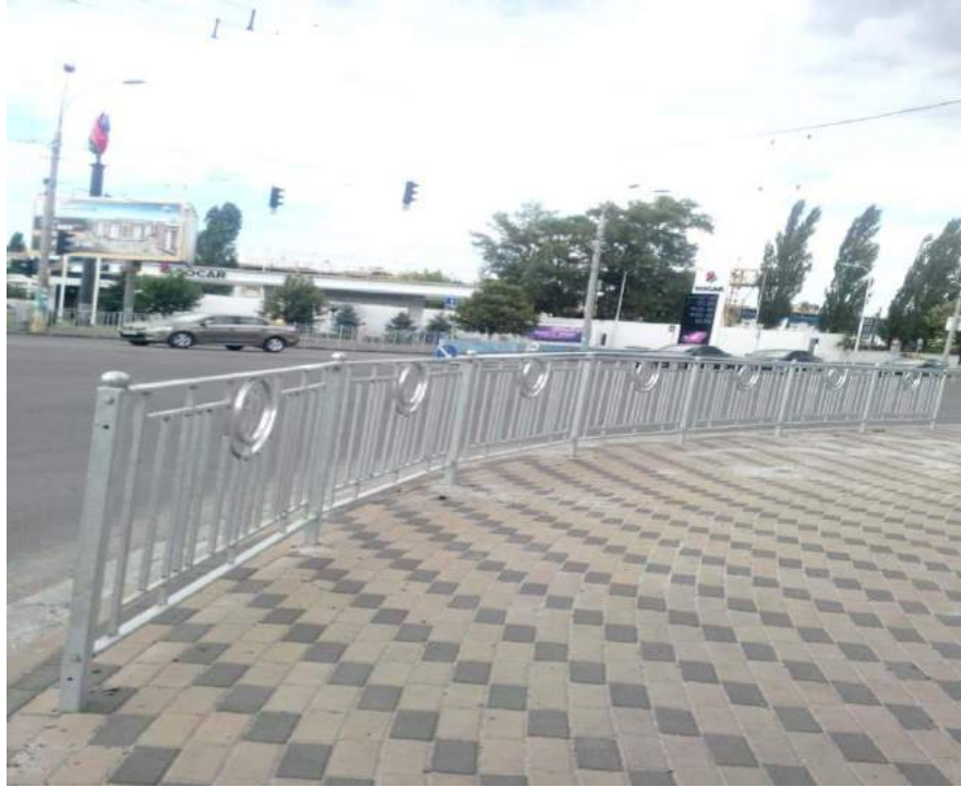
Капітальний ремонт, вул.Лугова
