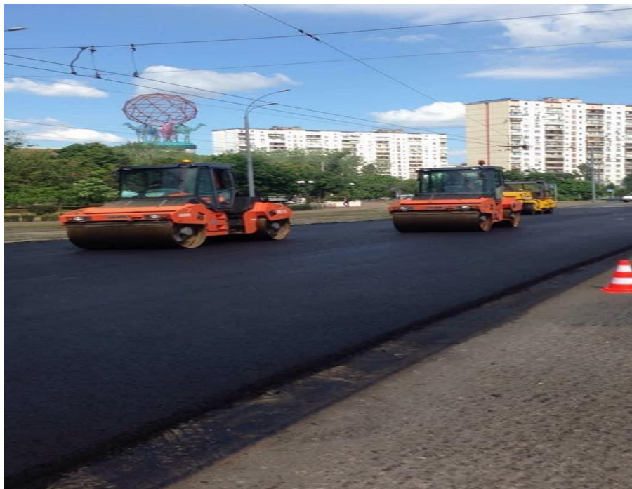
Середній ремонт на вулиці Йорданській
