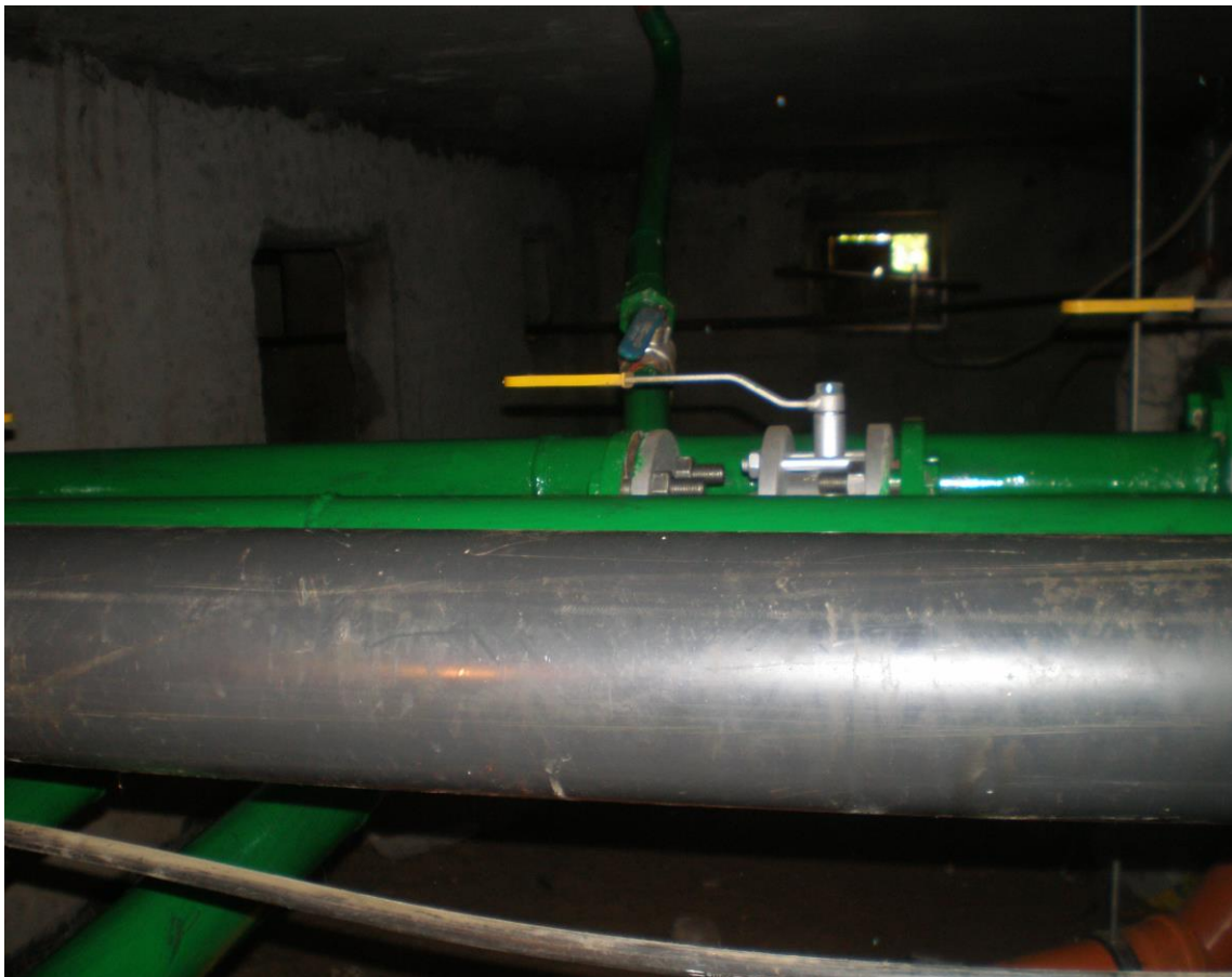
Ремонт внутрішньо будинкових інженерних мереж у будинку на просп. Оболонському, 23-Б.
