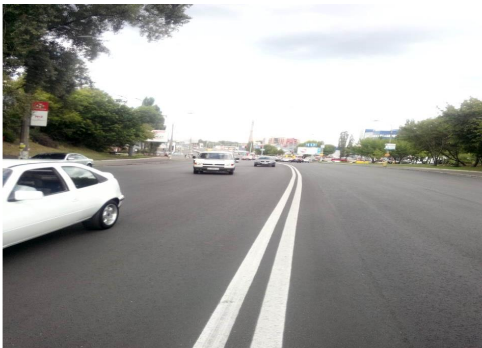
Капітальний ремонт, вул. Лугова
