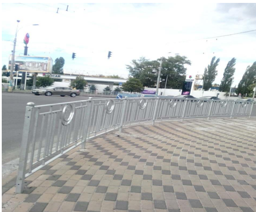
Капітальний ремонт, вул.Лугова
