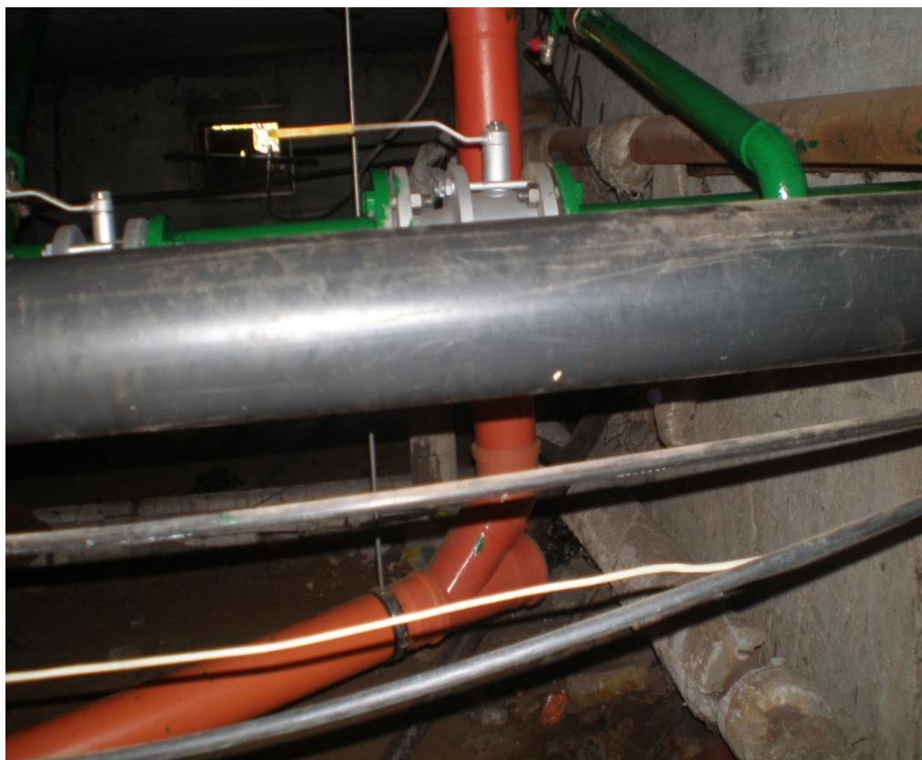
Ремонт внутрішньо будинкових інженерних мереж у будинку на просп. Оболонському, 23-Б.
