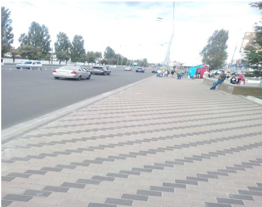
Капітальний ремонт, вул. Лугова
