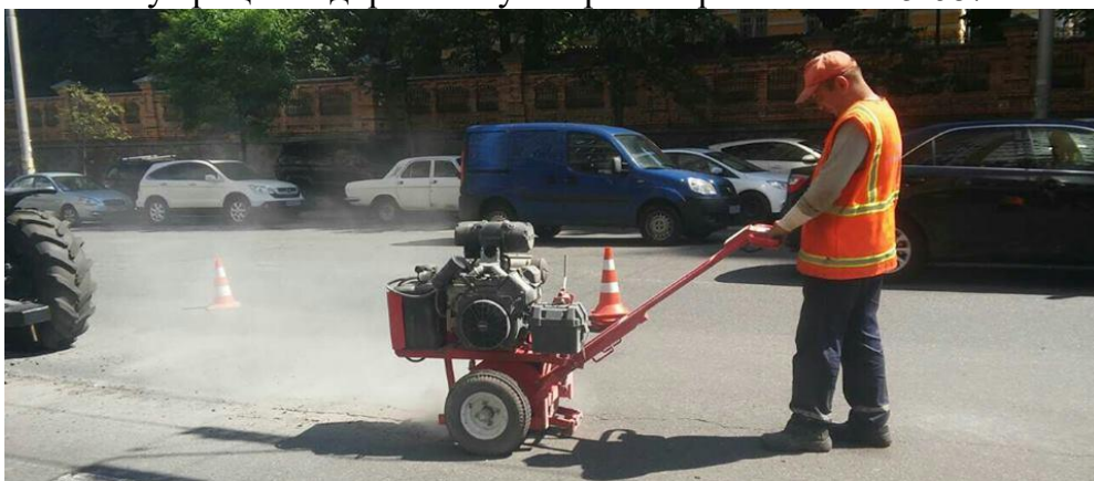
Підготовчі роботи перед заливкою тріщин
