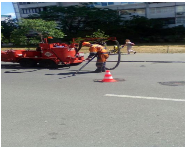
Заливка тріщин, проспект Оболонський
